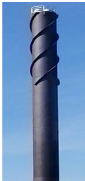
Fig. 2.9 Tall chimney fitted with helical strakes (Blevins, 1990)
