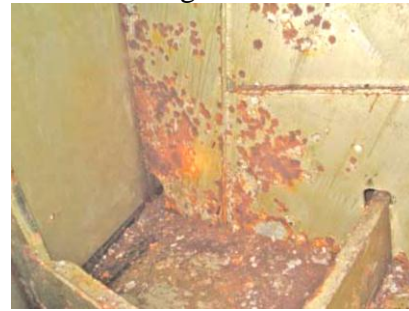
Fig 2.4 (d) Shallow pits > 15% Depth < 1/3 of original thickness
