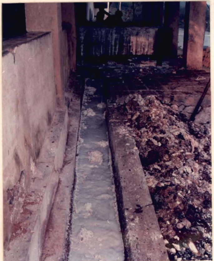
(b) Effluent discharge
